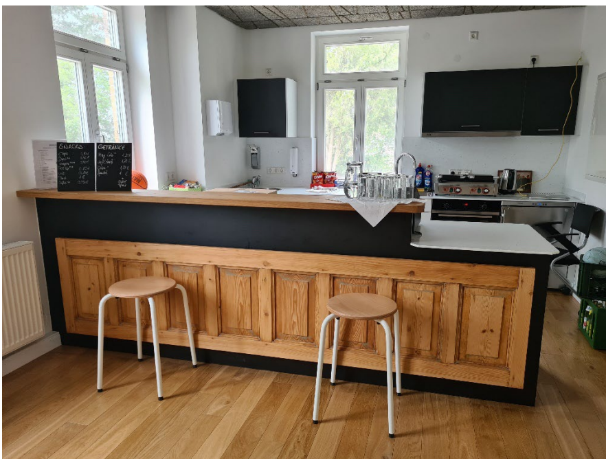
Die Holzvertäfelung wurde als Verkleidung für die Theke recycelt © stjg
